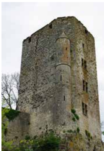
Fig. 6 : Le donjon du château de Chaudenay. Cliché B. Colas
